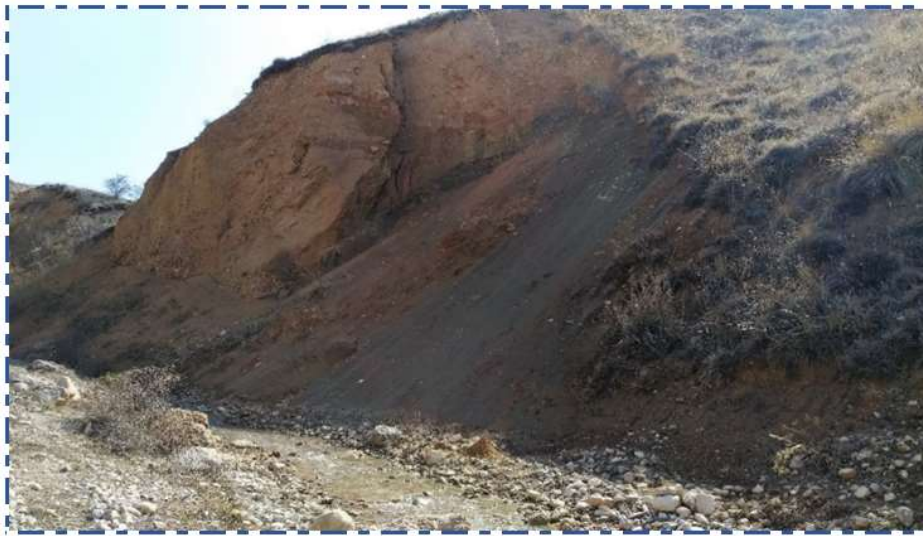
Şəkil 1. Havuşçay dərəsində sürüşmə.
