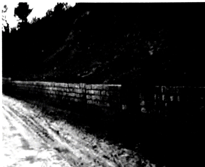
Рис. 2. Оползневые процессы на 17-18 км дороги Лянкяран-Лерик
