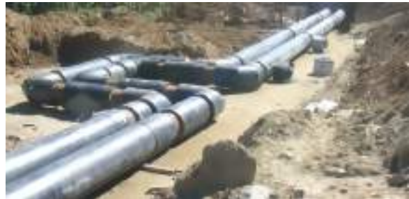
Şəkil 2 Boruların “П” formasında birləşdirilmiş hissəsi
