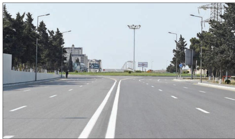
aradan qaldırılıb. Uzunluğu 2800 metr, hərəkət hissəsi 4-6 zolaqlı olan yolun yenidən qurulması zamanı köhnə asfalt örtüyü təmizlənib, zəruri yerlərdə yol yatağı bərkidilib və küçəyə yeni asfalt-beton örtüyü döşənib. Yenidənqurma işləri çərçivəsində küçəboyu hər iki istiqamətdə yeni piyada səkiləri yaradılıb, işıqlandırma sistemi qurulub. Bununla da şəhərin mərkəzi ilə 450 min nəfərdən çox əhalinin yaşadığı 8-ci Kilometr, Əhmədli və Gürəşli qəsəbələri arasında nəqliyyat əlaqəsi xeyli yaxşılaşıb.
