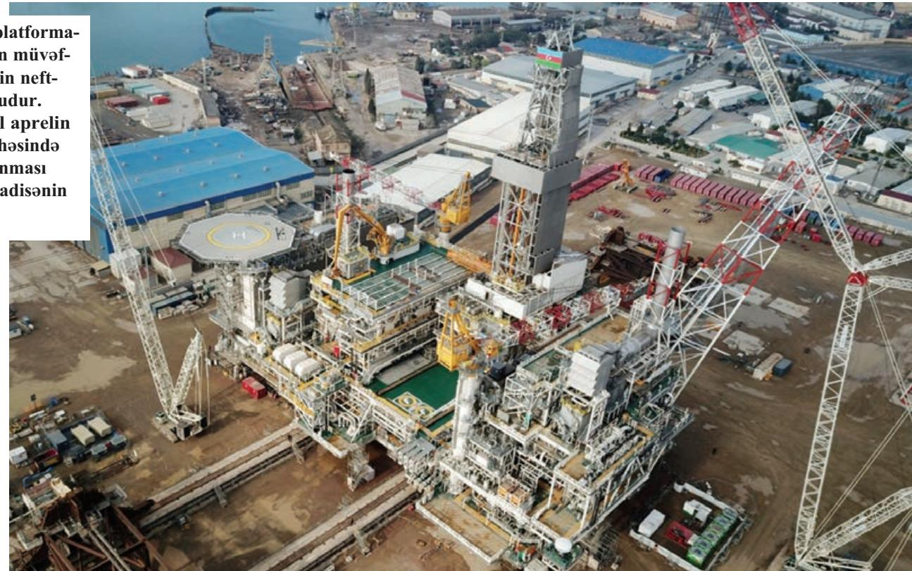
ibarətdir. Modulların layihələndirilmiş çəkisi 19 min 600 tondur. Üst modullar "Azfen" şirkəti tərəfindən yerli infrastruktur və resurslardan istifadə olunmaqla inşa edilib.
