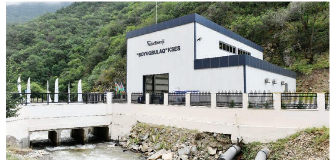
elektrik stansiyasının baş suqəbulədici qurğusu, 6 kilometr uzunluğunda derivasiya boru xətti, maşın zalı yenidən qurulub. Stansiyada Avropa istehsalı olan yaşıl sertifikatlı, iki müasir ekoturbin, generatorlar, idarəetmə və avtomatika panelləri quraşdırılıb. Stansiyanın enerjisistemə integrasi-
