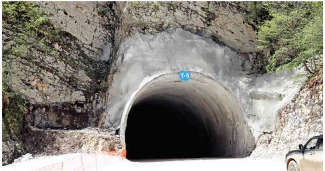
metrdir. Tunellərin 12,3 kilometrlik hissəsində qazma işləri tamamlanıb. Buradakı ən uzun tunel Murov dağının altından keçir. Həmin tunelin uzunluğu 11,6 kilometrdir.
