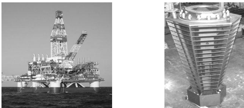
Рис. 3. Морская платформа ЛСП–Iи рыбозащитное устройство жалюзийного типа с потокообразователем
