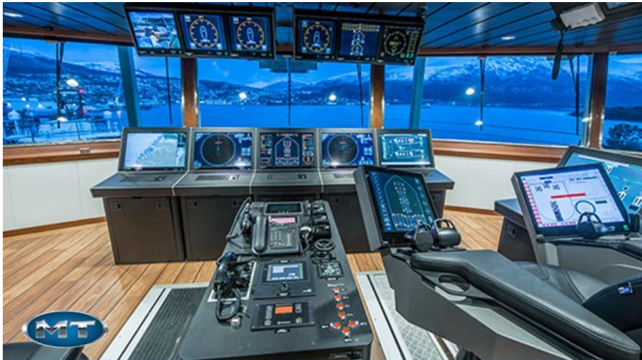
Şəkil 3. DP sistemi avadanlıqlarının kapitan körpüsündə yerləşməsi
