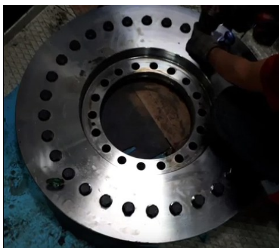
Рисунок 4. Вскрытие крышки демпфера
