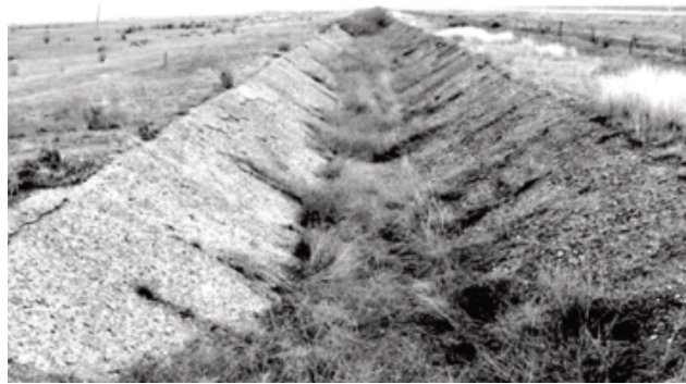
Sol Sahil kanalının mövcud vəziyyəti
