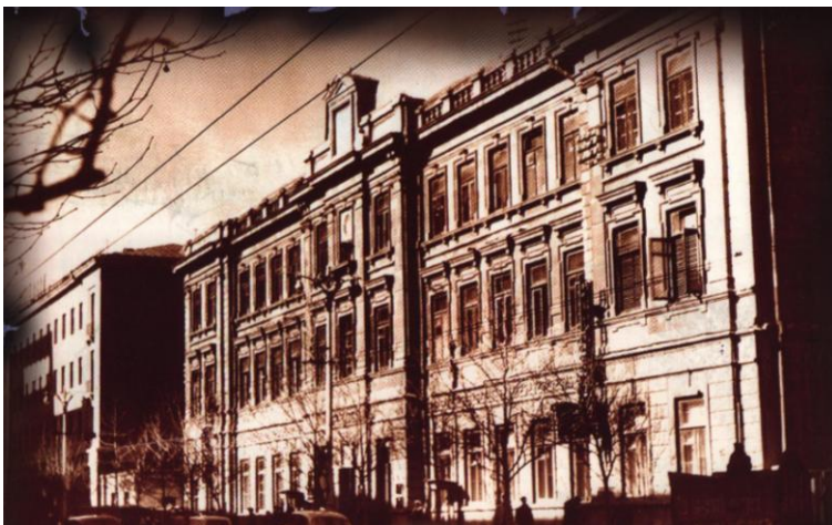
Poçt binasının bu günkü görünüşü. Hal-hazırda Rabitə və İnformasiya Texnologiyaları Nazirliyinin binası
