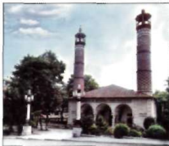
Mosquée de Govhar Agha, années 1883-1884 Architecte, Kerbélaï Safikhhan Karabaghi (1817-1910). Ville de Choucha.
