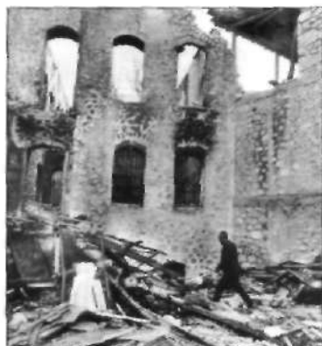
Les murs incendiés à la place de la maison.
